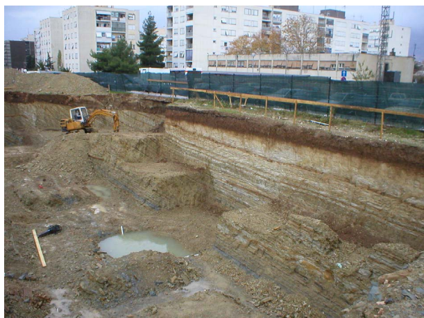
Slika 7. Primjer iskopa u flišu za temelje stambene zgrade
